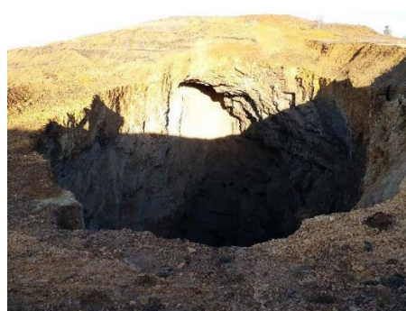
6-р зураг. Улааны далд уурхайн 1-р хүдрийн биетийн гадаргууд суулт үүссэн байдал [4]
