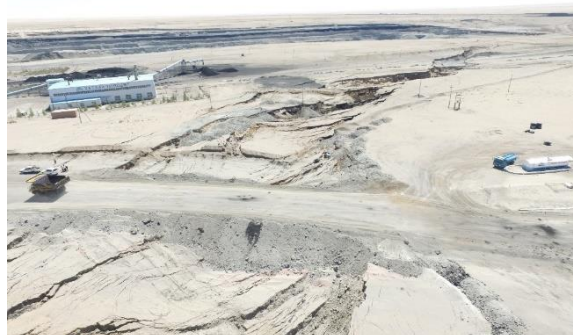
Зураг-2. Гадаад овоолго, ажлын бус хажуу, хатаах үйлдвэрийн баруун хойд хэсэгт үүссэн хагарлын шугам 2018 оны 5-р сарын 30-ны байдлаар
