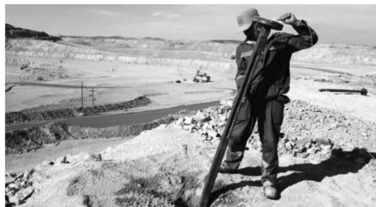
8-р зураг. Цооногт агаарын зайн хуванцар тулгуурыг байрлуулж буй байдал
