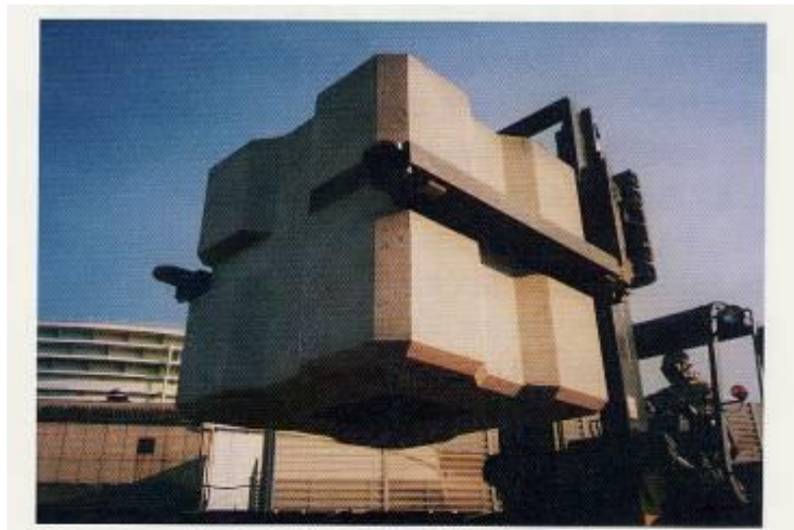
写真-1 フォークリフトで移動中の石炭灰硬化体ブロック (1.6 m角, 6t)
