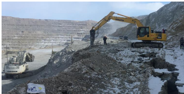
11-р зураг. Ил уурхайн баруун урд хажуугийн ажлын догол саравчилсан ирмэгийг буулгаж буй ажиллагаа
