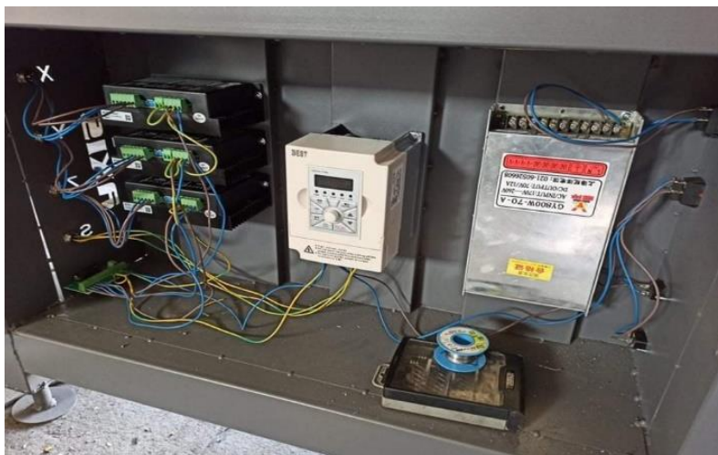
2.2-р зураг. Цахилгааны мантаж хийсэн байдал
