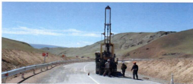
Зураг 8 . 78+980 : K79+240 зурваст өрөмдлөг хийж буй нь
