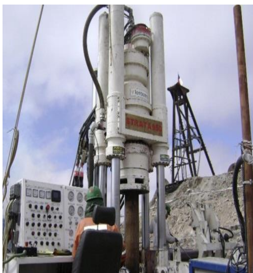
1 дүгээр зураг. Өрөмдлөгийн T-130 төхөөрөмж
