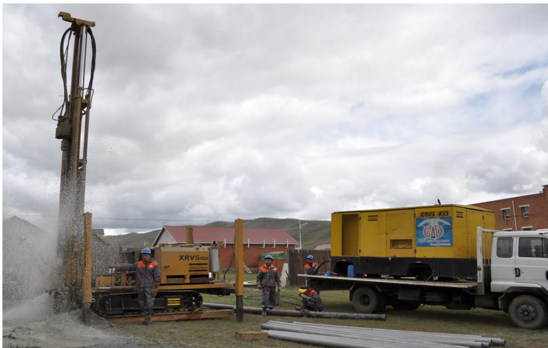
2 дугаар зураг. Усны хийн цохилтот-эргэлтэт (хийн хөөрцөгт) өрөмдөг
