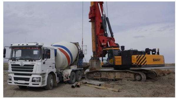
Тулгуурын бетон цутгалт
