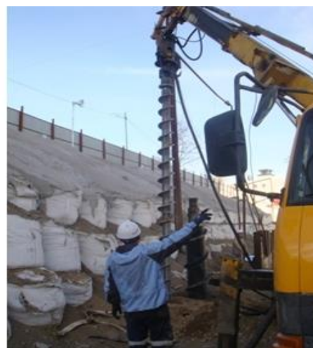
Шургийн далбааны дагуу механикаар болон хөндийгөөр нь компрессороор үлээлгэж шороогоо гаргах ажиллагаатай хийн цохигч, том голчийн шургин өрөмдлөгийн төхөөрөмжийн иж бүрдэл ажлын байдалд...
