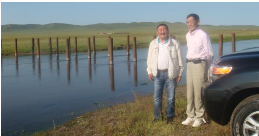
Улзын голын шинэ гүүрийн өрөмдлөгөөр босгосон тулгуурууд (2014 оны 8-р сарын эх, 10-р сард энэ гүүр ашиглалтанд орсон)
