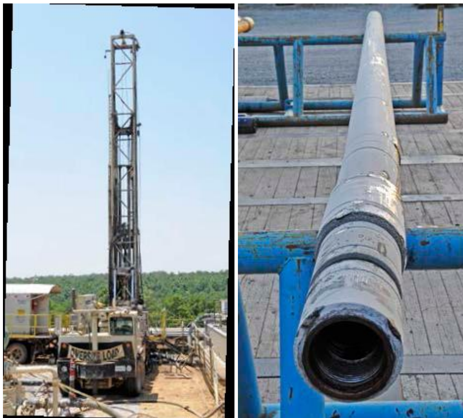
Зураг.5 Зүүн талд: Атлас Копко RD20 өрмийн төхөөрөмжөөр угаалгын шингэн ашиглан чиглэлтэй өрөмдлөг гүйцэтгэж байна. Угаалгын шингэний сан (баруун талд), хоёр ширхэг угаалгын шингэний шахуурга нь чиглэлтэй моторыг эргүүлэх угаалгын шингэн шахдаг.
