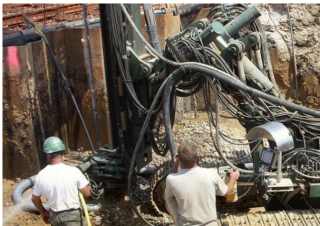
Зураг 3. ВАР-160 LUBAP төхөөрөмжийг өрмийн төхөөрөмжинд суурилуулсан байдал
