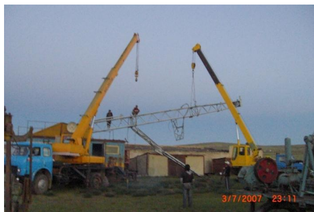
Зураг-5. Зүүнбаянгаас ЗИФ1200МР өрмийн төхөөрөмжийг полигонд авч ирж угсрав (2007он)
