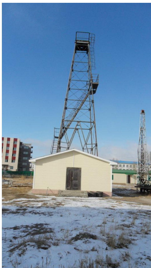
Зураг-10. Тохижолт засварын ажил хийсний дараах гүний өрмийн байр, оюутны байрны урд тал (2013 он)
