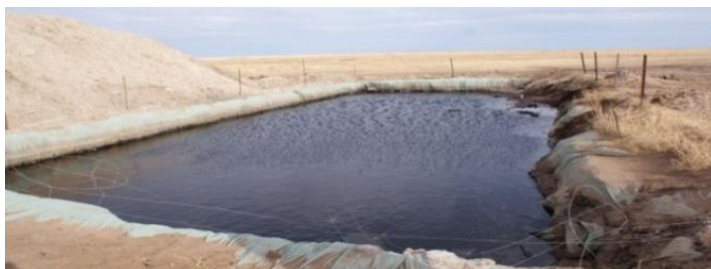
1 дүгээр зураг. Өрмийн шингэн хаягдлын сангийн хамгаалалтын хальс урагдсан байгаа байдал (19-р талбай Тосон-Уул)
