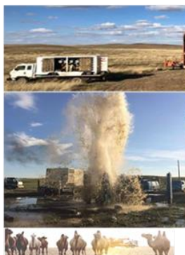
Худаг усны өрөмдлөг Water Well Drilling
