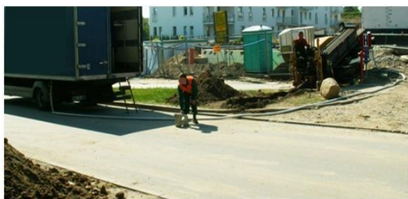
7 дугаар зураг. Туршилтын өрөмдлөг тавьж буй нь
