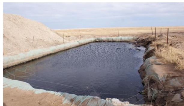
3 дугаар зураг. Өрмийн шингэн хаягдлын сангийн хамгаалалтын хальс урагдсан байгаа байдал (19-р талбай Тосон-Уул) [3]
