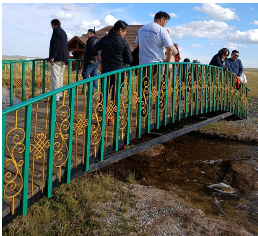
8 дугаар зураг. Бөөрөлжүүтийн нүүрсний ил уурхайн 1 дүгээр нуураас дараагийн нуур руу цутгасан голын гүүр. 2025-09-09. Фото зургийг Р.Алтанчимэг
