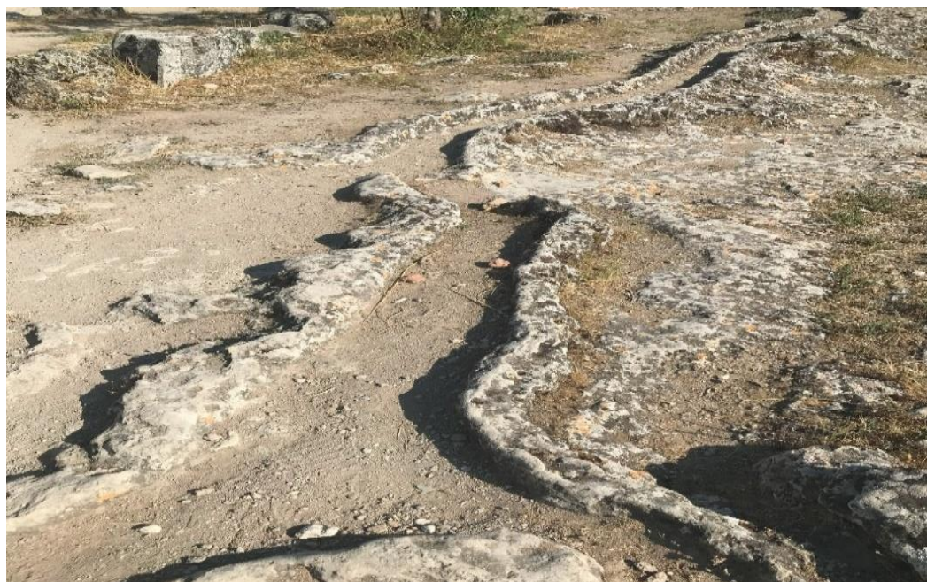
Зураг 3. Ус хангамжийн инженерийн байгууламж. 2025.05.31 (Фотог П.Хөхөө)
