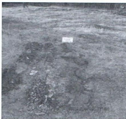
Зураг 17-20. Богд хааны музейн ордон музейн барилгын талбайд илэрсэн ул хөрсний судалгааны явц, дээжлэлт ба цооног буцаан булсан байдал. 2019-03-18.
